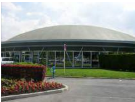
Drancy - Stade nautique municipal Boulevard Paul-Vaillant-Couturier Ch. Bouillard, R.C. Marcoz, architectes, Du Château, ingénieur © CG93, DCJS, BP, cl. Ph. Charpin, 2003 029INV089
