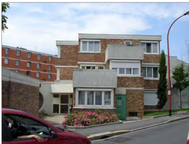
Drancy - Foyer de personnes âgées Les Lilas Rue Jane Joye AUA, Paul Chemetov architecte, Ville de Drancy, 1970-1972. © CG93, DCJS, BP, cl. B. Pouvreau, 2003
