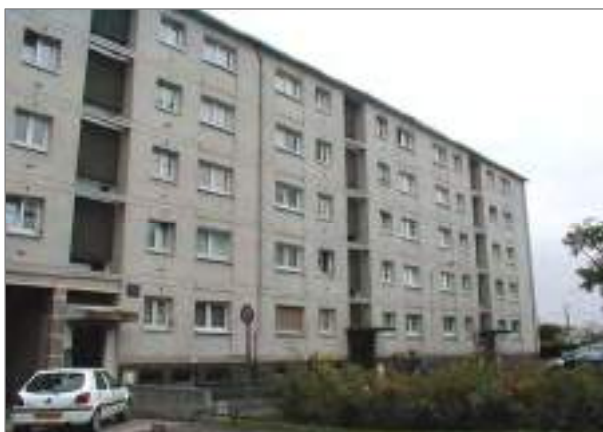
Drancy - Cité de la Muette Square de la Libération 98 logements (HLM-O), Lods Marcel et Malizard, architectes, ODHLM, 1955-1956 © CG93, DCJS, BP, cl. B. Pouvreau, 2003
