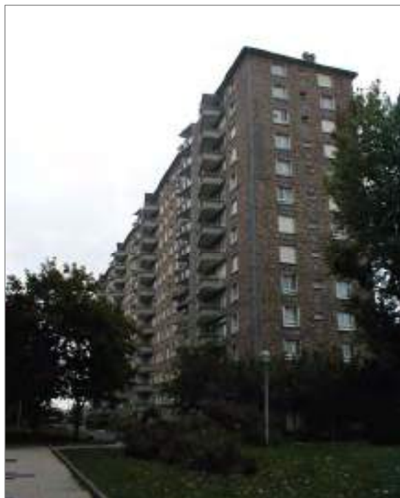
Drancy - Cité P. Vaillant-Couturier Rue Anatole France et avenue P. Vaillant-Couturier 403 logements (HLM-O), Marcel Lods architecte, OPHLM de Drancy, 1957-1958, modèle établi à Sotteville-les-Rouen. © CG93, DCJS, BP, cl. B. Pouvreau, 2003 029INV051
