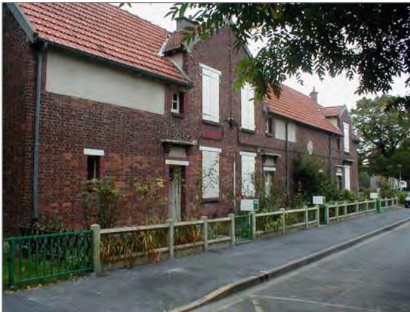
Drancy - Cité-jardin Rue Soubiran, rue Charles-Gide et rue de la République Joseph Bassompierre, Paul de Rutté, architectes : OPHBM de la Seine d'Henri Sellier et C ie des chemins de fer de l'Etat, propriétaire du terrain, 156 logements, 1921-1922 pour les pavillons puis extension en 1929-1933. La première cité-jardin est partiellement détruite en 1996. © CG93, DCJS, BP, cl. B. Pouvreau, 2003 029INV053
