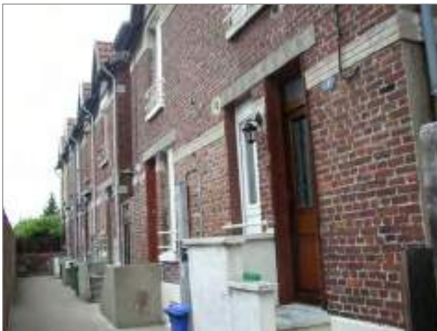
Drancy - Logements ouvriers 189, avenue Henri-Barbusse Début du XXème siècle © CG93, DCJS, BP, cl. B. Pouvreau, 2003
