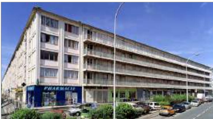
Drancy - Cité de la Muette Avenue J. Jaurès, rues Fontaine et Blanqui Vue de la façade arrière le long de l'avenue Auguste Blanqui. © Inventaire général, Département de la Seine-Saint-Denis, cl. S. Asseline, ADAGP, 2003 029INV052
