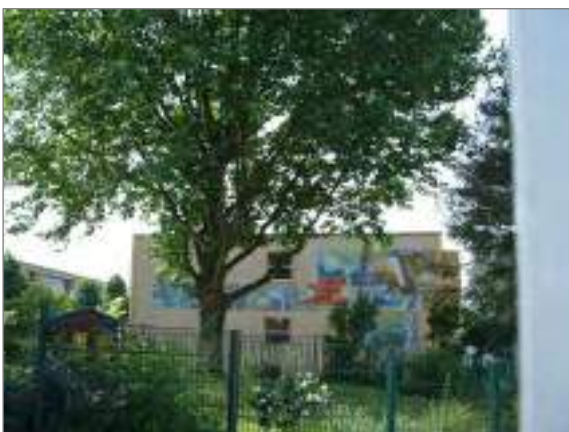
Drancy - Ecole primaire Cristino-Garcia 88 rue Saint-Stenay R. Gilbert, architecte, 1965 © CG93, DCJS, BP, cl. A.-Cl. Baratault, 2003 029INV095
