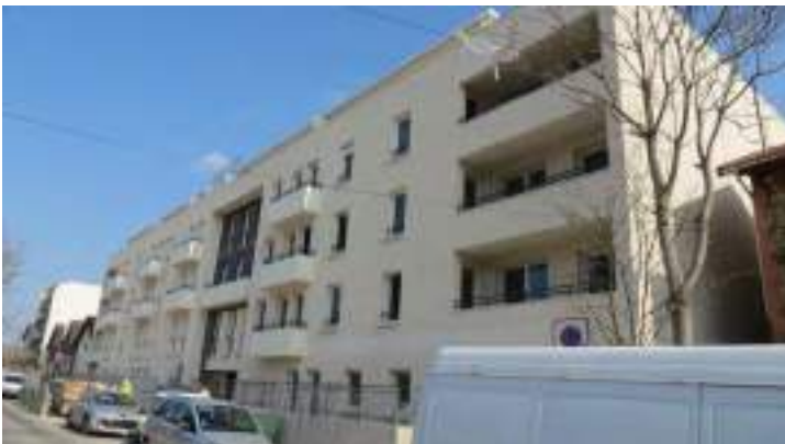
Résidence récente au Nord de Drancy
