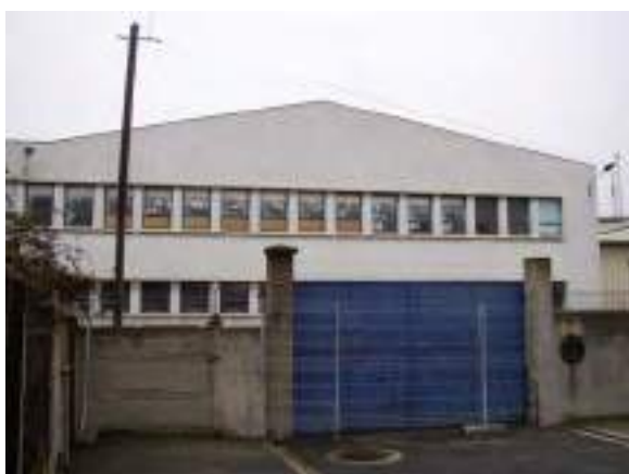
Drancy - Atelier de fabrication de l'entreprise ELM Leblanc 121-123, rue Diderot © CG 93, DCJS, BP, cl. A. Furio 029INV003
