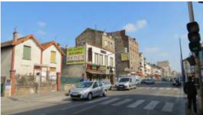
Bâti le long de l'Avenue Marceau
