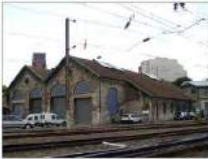
Drancy - Atelier de réparation et d'entretien Gare de triage. Dernier quart du 19 e siècle. © CC03, D.C.S, EP, et A. Furet, 2003 029eu107
