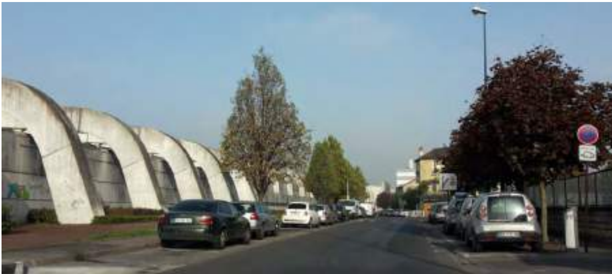
Viaduc A86 (Photo : Synthèse Architecture)
