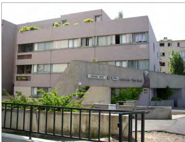
Drancy - Résidence Max Jacob 184-186 av. Henri-Barbusse 40 logements (PLA), AUA, Jean et Maria Deroche architectes, OPHLM, 1974-1977. © CG93, DCJS, BP, cl. B. Pouvreau, 2003
