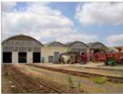
Drancy - Atelier de réparation et entretien Gare de triage Structures charpentes et voûtes en béton. Premier quart du 20 e siècle. © CC03, D.C.S, EP, et A. Furet, 2003 029eu118
