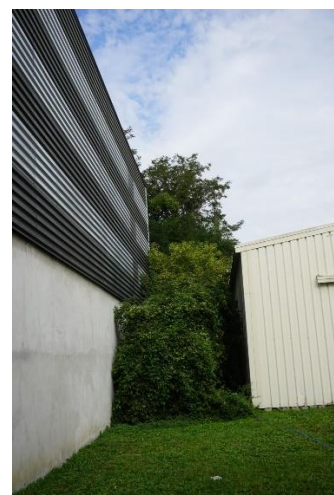
Mur du côté de la zone d'entrepôts du Bourget
