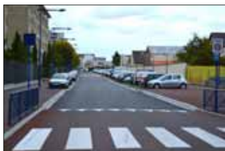
* La rue Emmanuel Vinson entièrement refaite et le parking.
